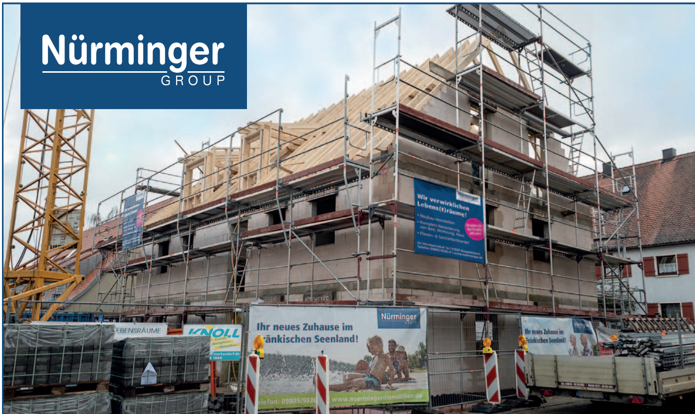
Mit dem Richtfest wurde die Rohbauphase für das zweite 6-Familienwohnhaus beendet. (Fotos: Nürminger)
